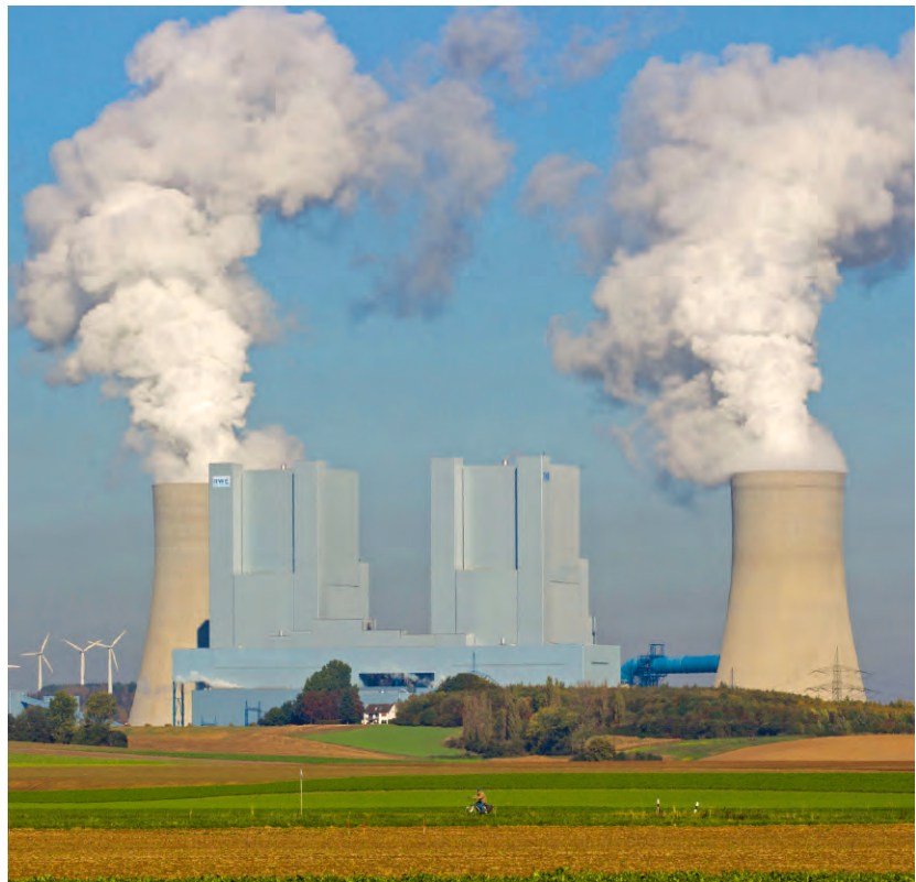
Das modernste Braunkohlenkraftwerk der Welt - BoA 2&3 in Neurath, NRW
